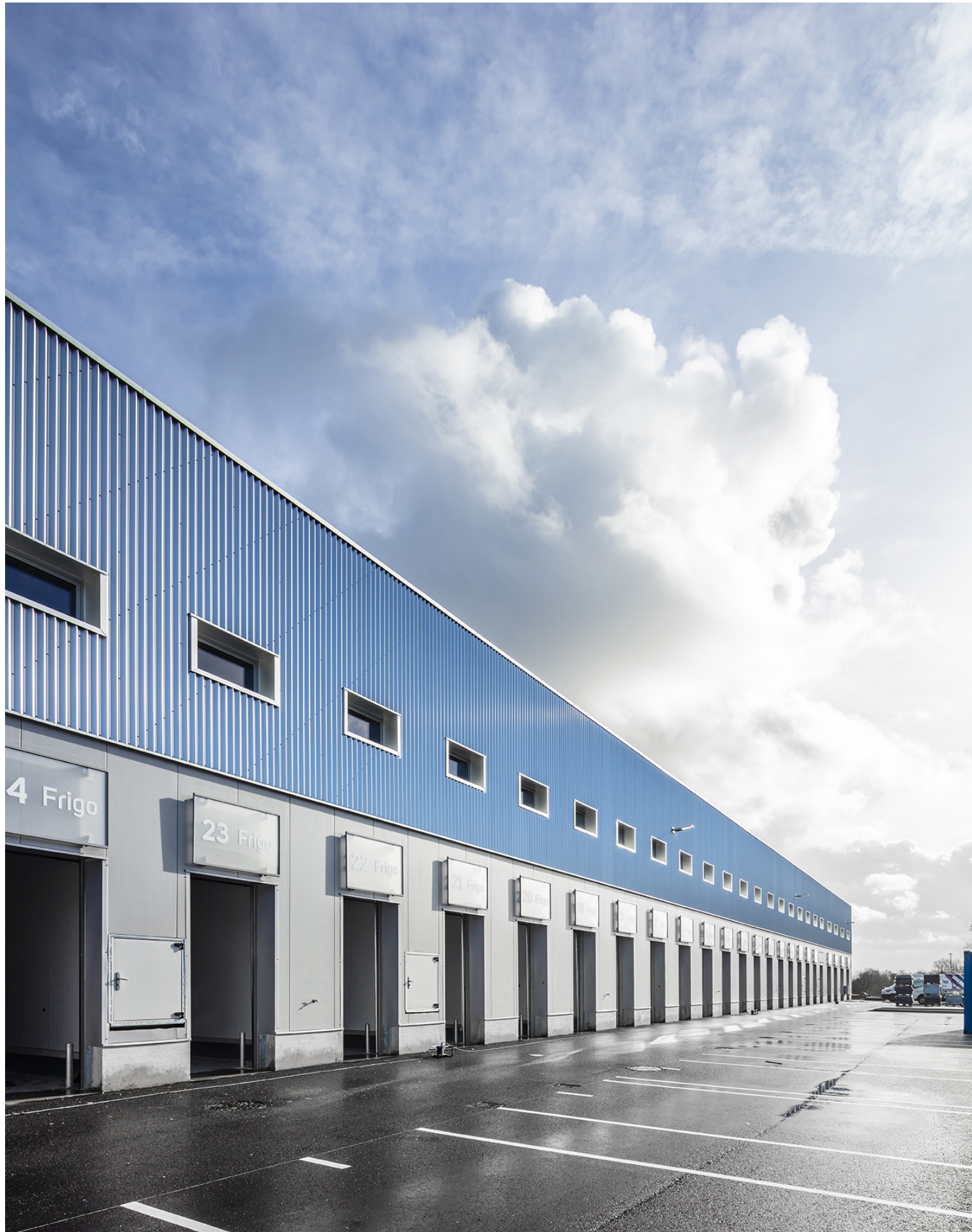
Zone de déchargement VUL | Bâtiment G
