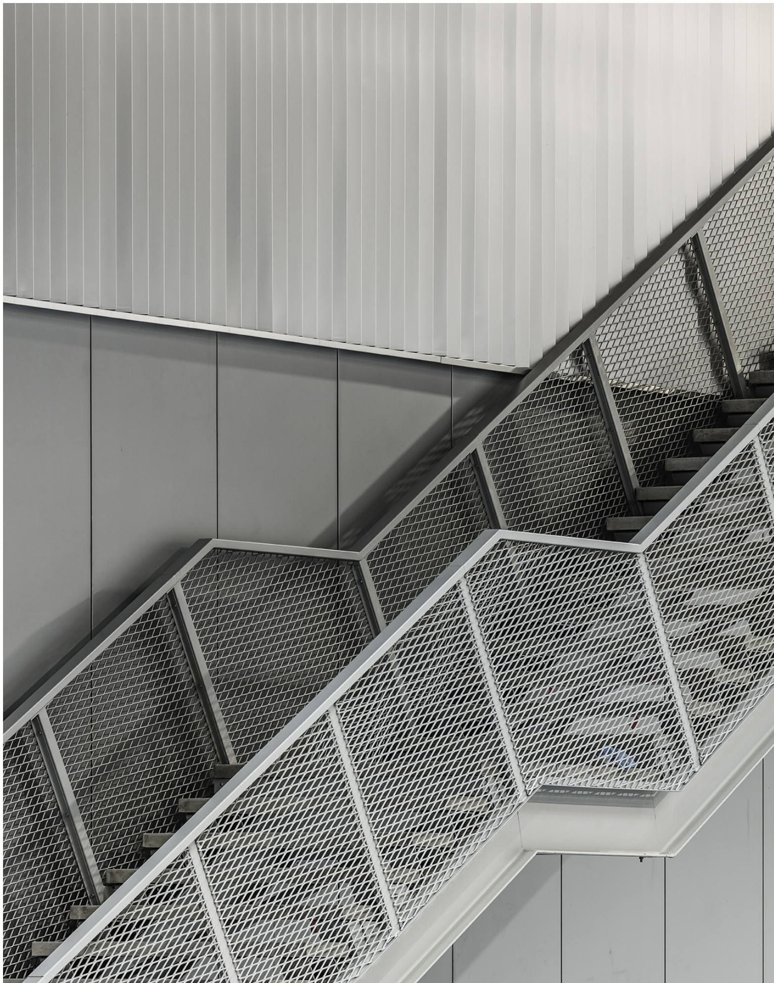
Escalier d'accès aux coursives R+1 / Bâtiment A
