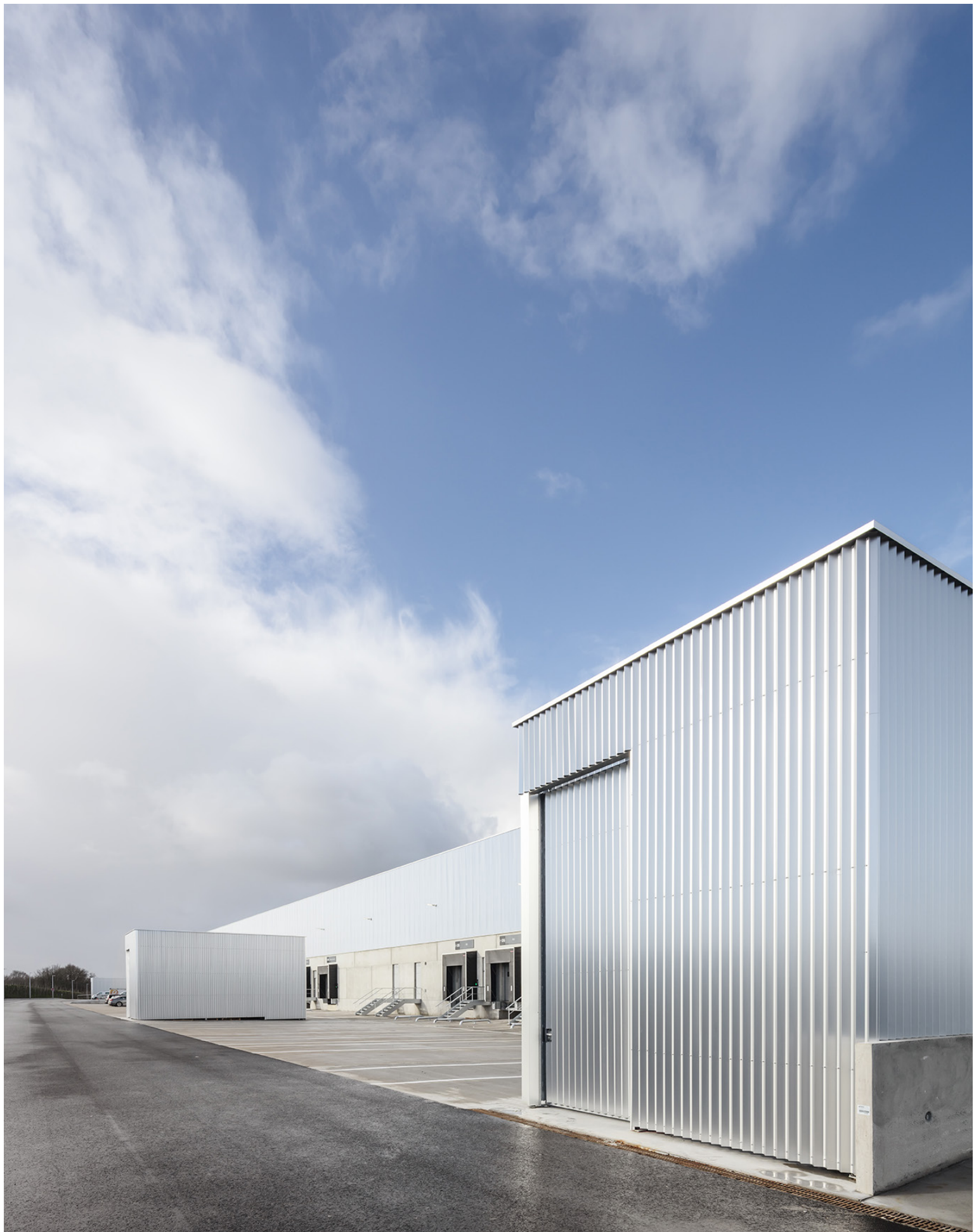
Locaux de stockage
